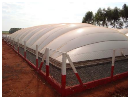
Figura 5 - Biodigestor de sistema contínuo
