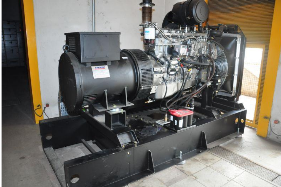
Figura 9 - Modelo de instalação de um conjunto motogerador
