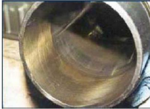
Figura 28 - Superfície dos cilindros comprometida pela presença de siloxanos
