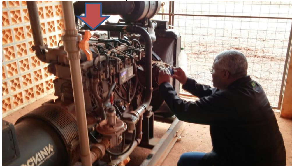
Figura 20 - Linha de abastecimento de biogás com motor aspirado adaptado da Granja Haake
