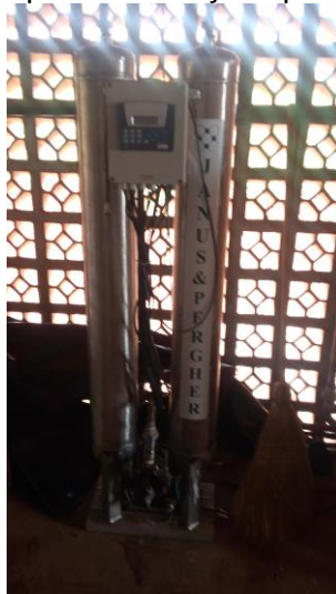
Figura 69 - Coluna dupla de adsorção tipo PSA da Granja Haacke
