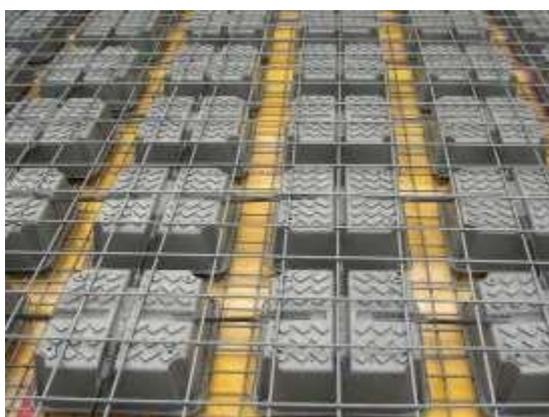
Figura 55: Instalação das Fôrmas *U-Boot Beton*®
