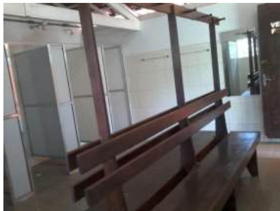
Figura 26 - Área interna, vestiário feminino
