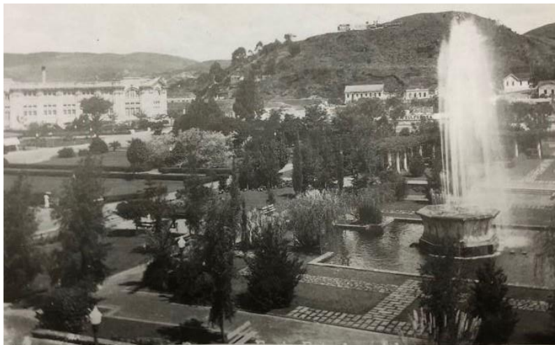
Figura 5: Parque Romântico em Poços de Caldas Fonte: MACEDO, SAKATA, 2003
