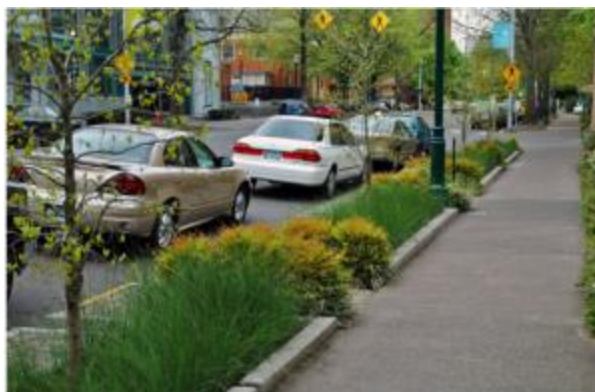
Figura 10: Exemplo de jardim de chuva na cidade de Portland, EUA Fonte: Site Infra verde
