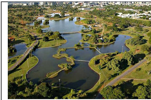
Figura 22: Vista aérea da zona do Lago Fonte: Site WBrasília
