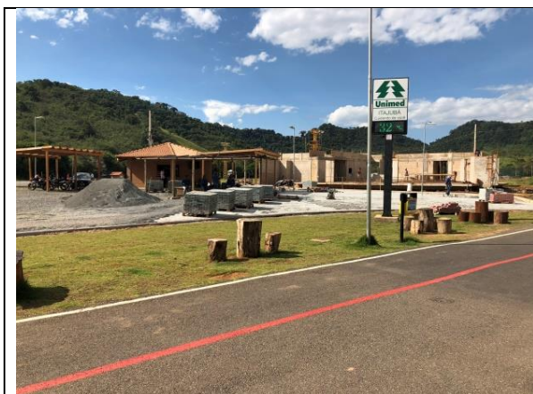
Figura 69: Quiosque de alimentação e restaurante em construção
