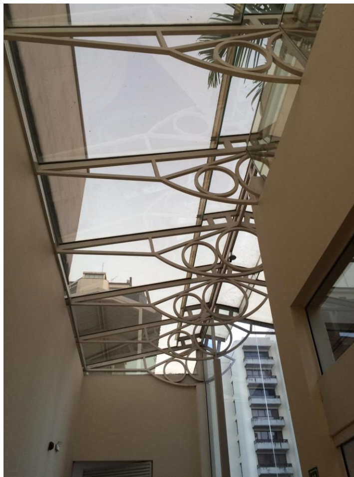
Figura 42: Teto de vidro na área central do edifício.
