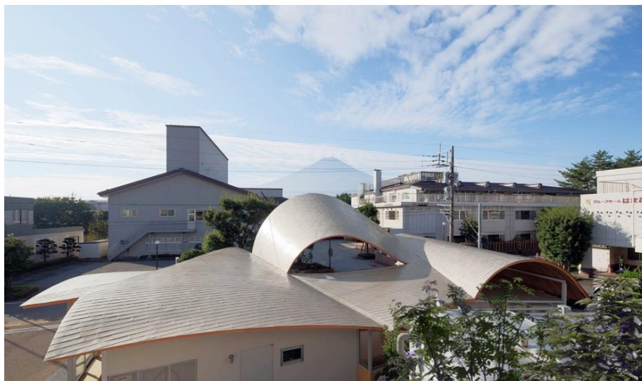
Figura 17: Vista superior para ver o telhado
