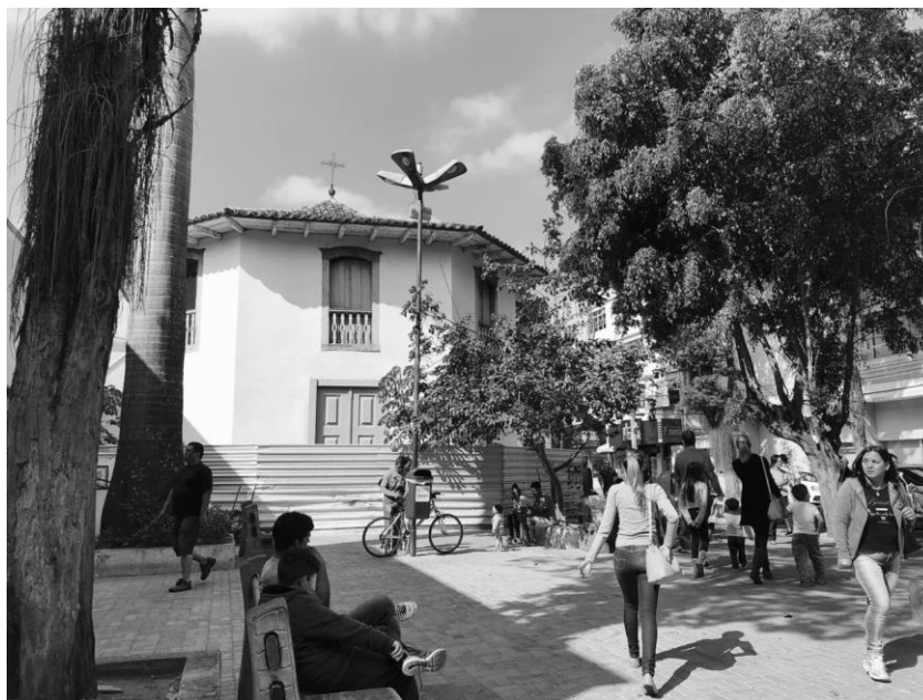
Fig. 31: Foto da fachada da Capela Nossa Senhora do Pilar.
