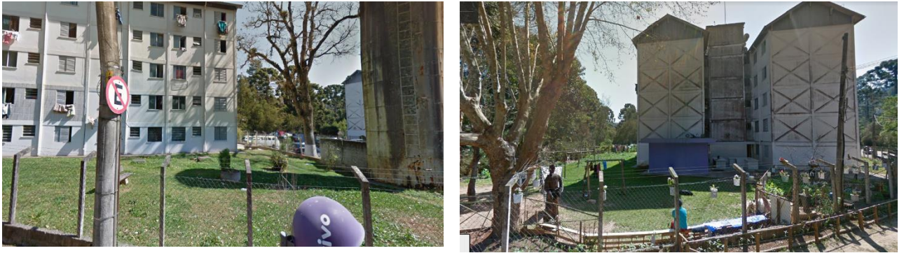
Figura 29. Foto do Conjunto Habitacional em Campos do Jordão - Fonte: Acervo da Autora.
