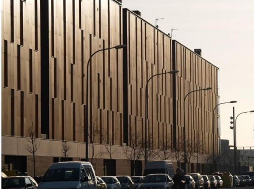
Figura 25. Conjunto Habitacional Fira de Barcelona – L'Hospitalet de Llobregat, fachada norte, Barcelona 2009 - Fonte: Foto Gianluca Giaccone [ONL Arquitectura]
