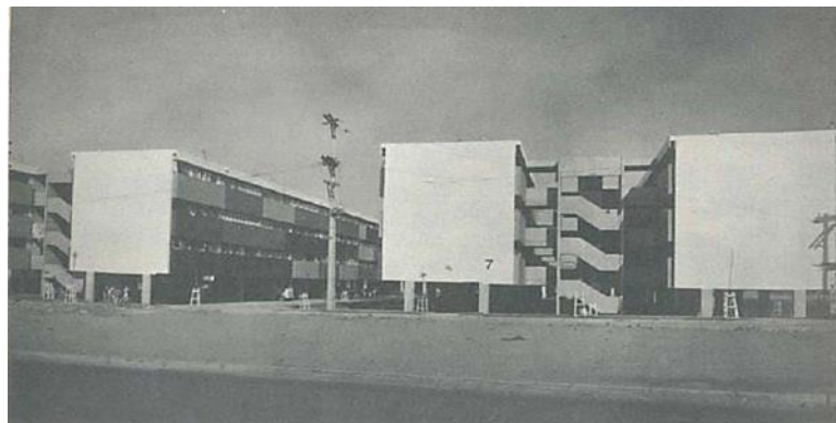
Figura 12. - Edifícios da primeira fase de construção – Fonte: Laboratório de Artes Gráficas da FAAUSP.
