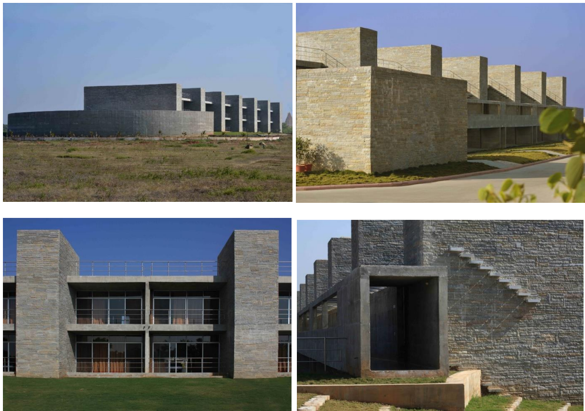
Figura 52 - Conjunto da Casa de Hóspede Pavapuri
