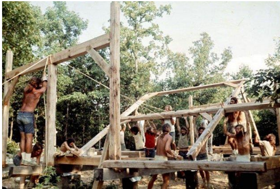
Figura 3: Construção com madeira onde toda a comunidade participa.
