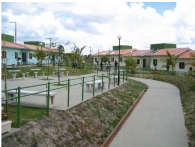
Figura 27: Rampas para acesso.
