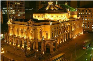
Figura 14: fachada do Teatro Municipal de São Paulo, SP.
