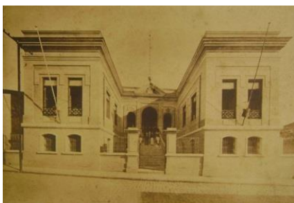
Figura 26: Ginásio do estado
