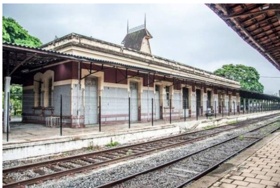
Figura 22: Estação Ferroviária de Taubaté
