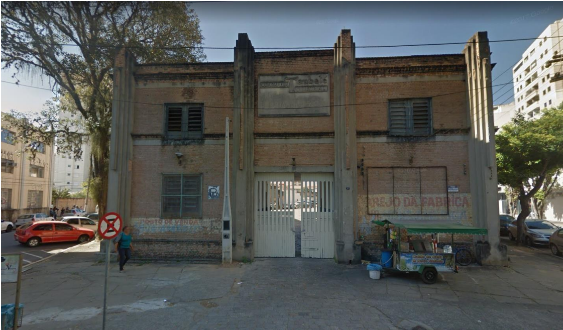
Imagem 66: fachada da Quadra B, vista da praça da CTI
