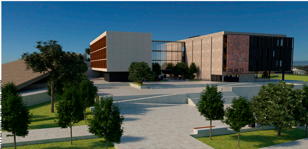
EXTERIOR DO EDIFÍCIO
