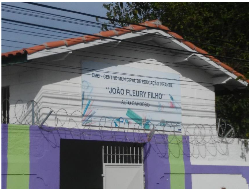
Figura 29: Fachada da Escola João Fleury
