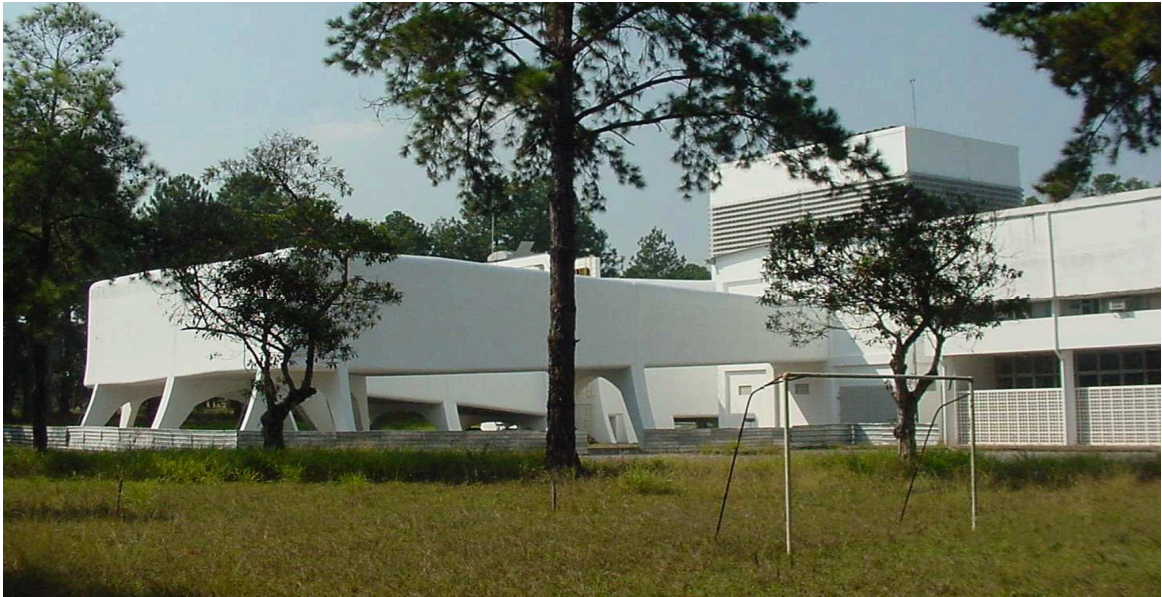
Figura 06 - O prédio e o circuito após a reforma (SADAHAKI, CHISAKI, 2008)
