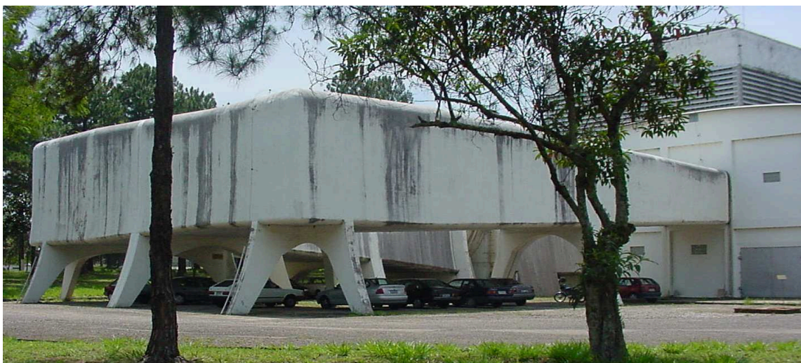
Figura 05 - Estado do prédio e do circuito antes da reforma (ALA, 2003)
