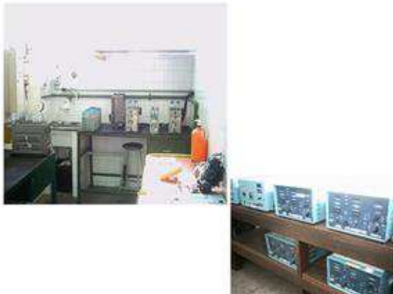
Figura 31 Oficina de Baterias
