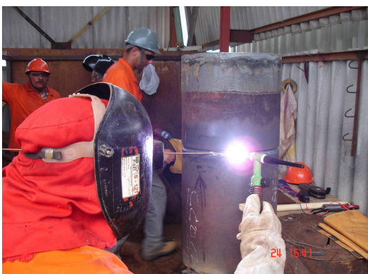
Figura 31 - Soldagem da junta (fonte: autor)
