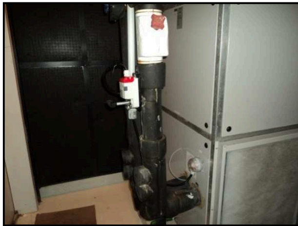
Figura 17 – Atuador Válvula de água Gelada Fonte: RECORD (2010)
