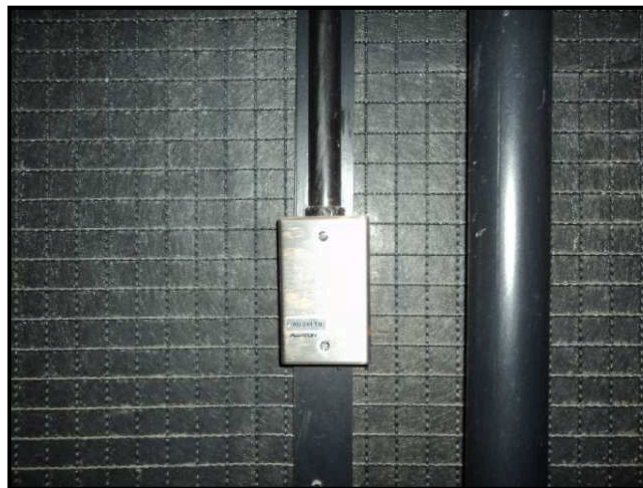
Figura 07 – Sensor de Temperatura Estúdio I Fonte: RECORD (2010)
