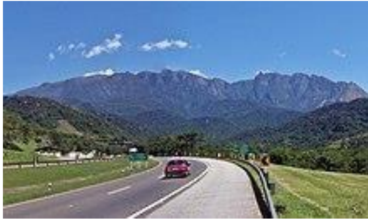
Figura 8 - Trecho da BR-116 na Região Serrana do Rio de Janeiro
