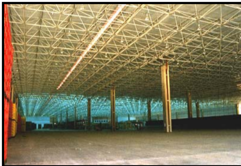
Figura 4 – Parte da estrutura de cobertura da cervejaria Brahma
