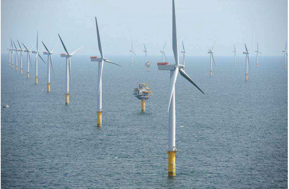
Figura 39 – Sistema de geração offshore
