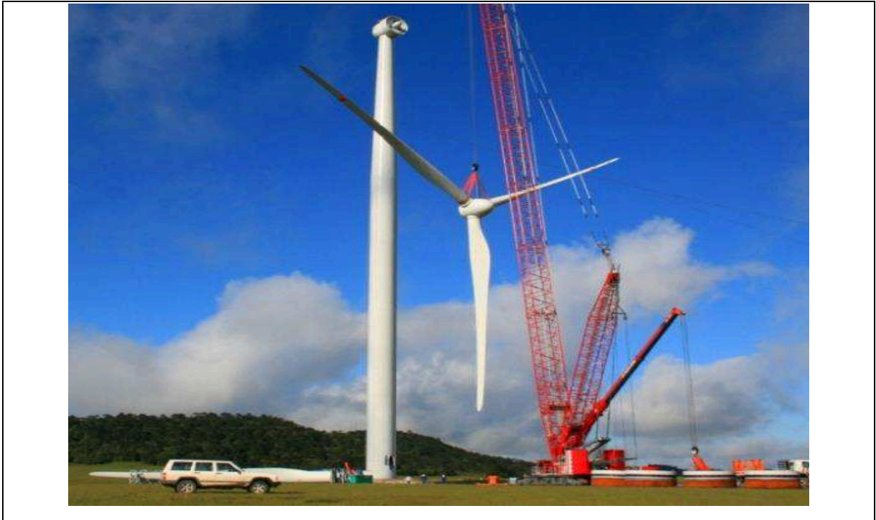
Figura 21 - montagem de um aerogerador:
