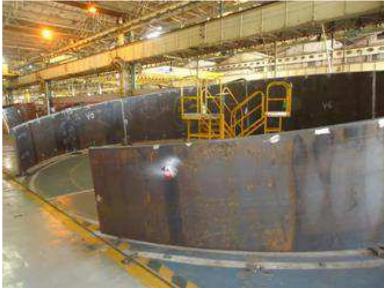
Figura16 - Virola posicionada sobre calços nivelados
