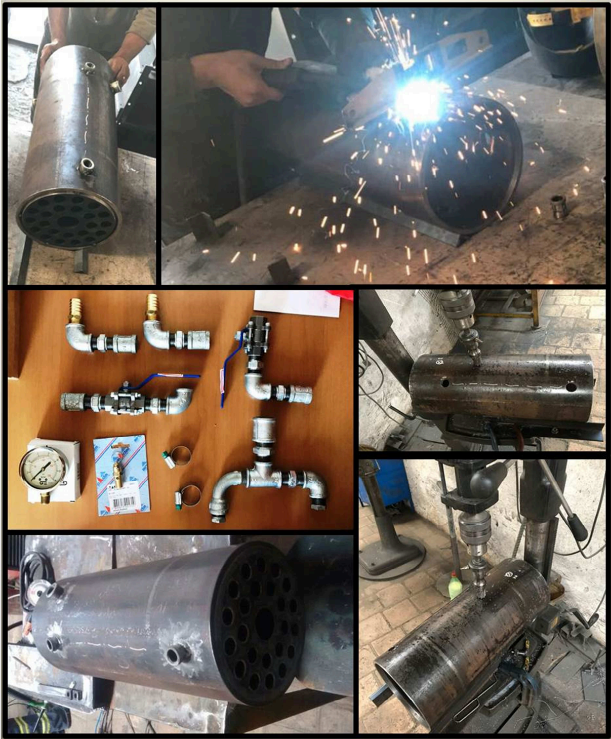
Figura 28 – Detalhes dos furos, conexões soldadas e válvulas
