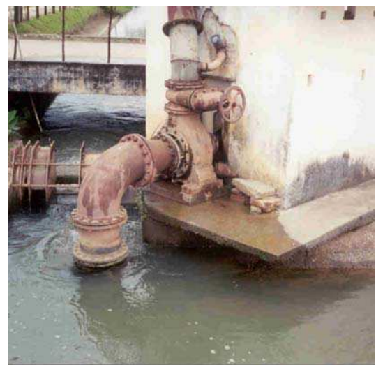
Figura 14 – Bombeamento para o canal suspenso
