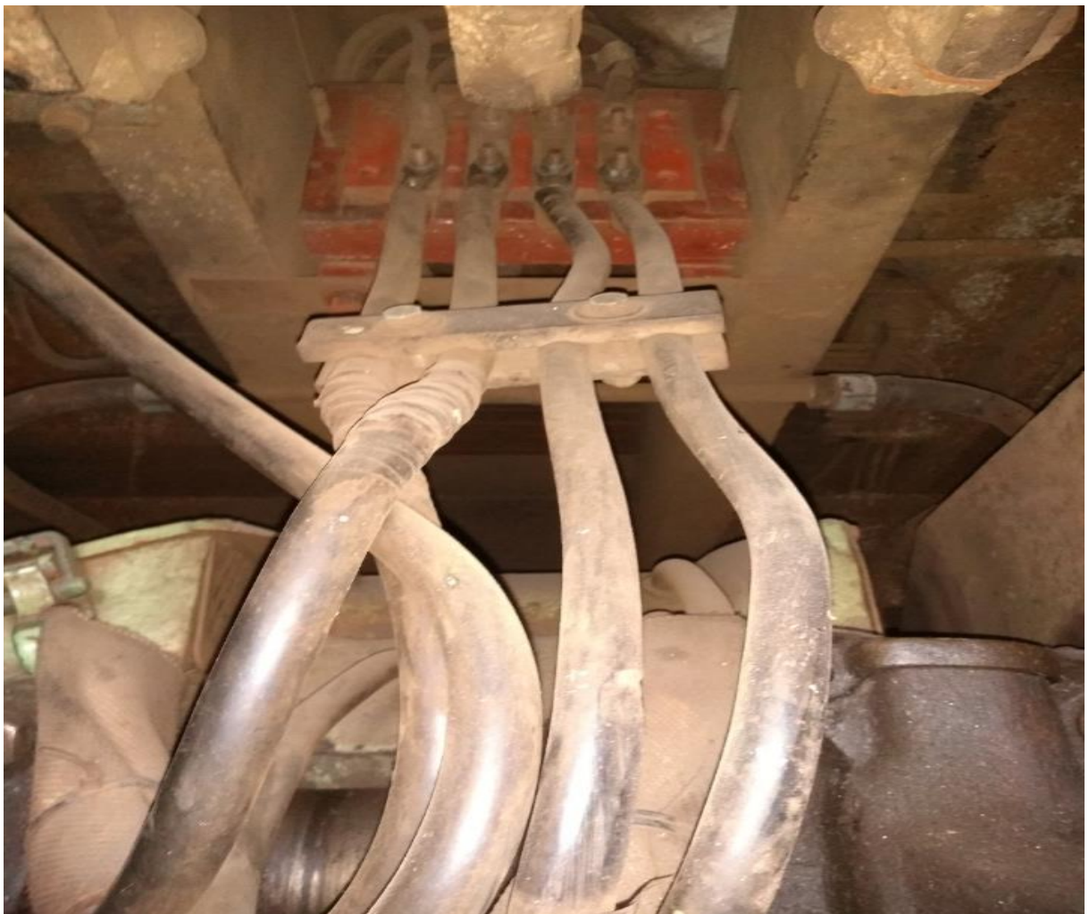
Figura 27: Caixa de ligação dos cabos do motor da automotriz
