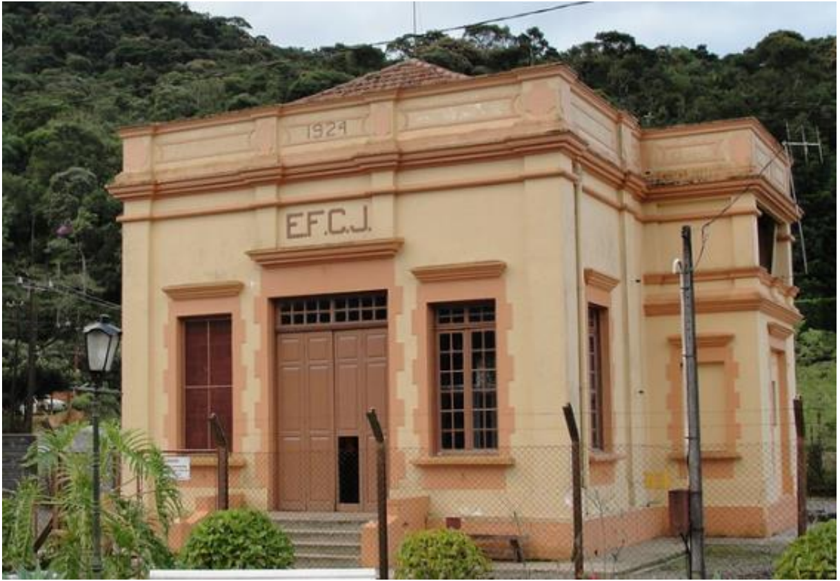
Figura 30: Subestação em Santo Antônio do Pinhal
