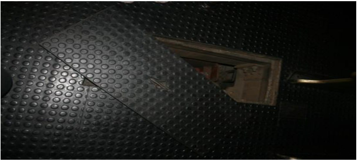
Figura 26: Tampa de inspeção no assoalho da automotriz
