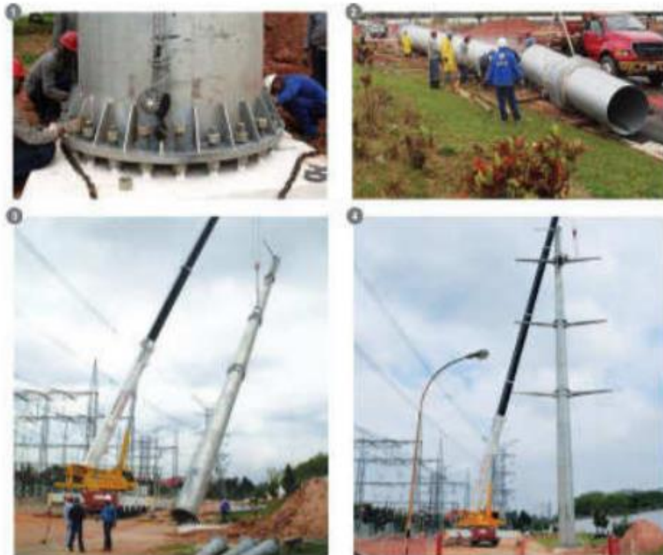
Figura 3 - Processo de montagem da torre monotubular
