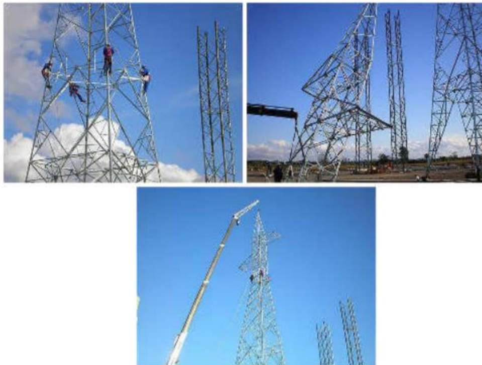
Figura 4 – Montagem da Torre Treliçada
