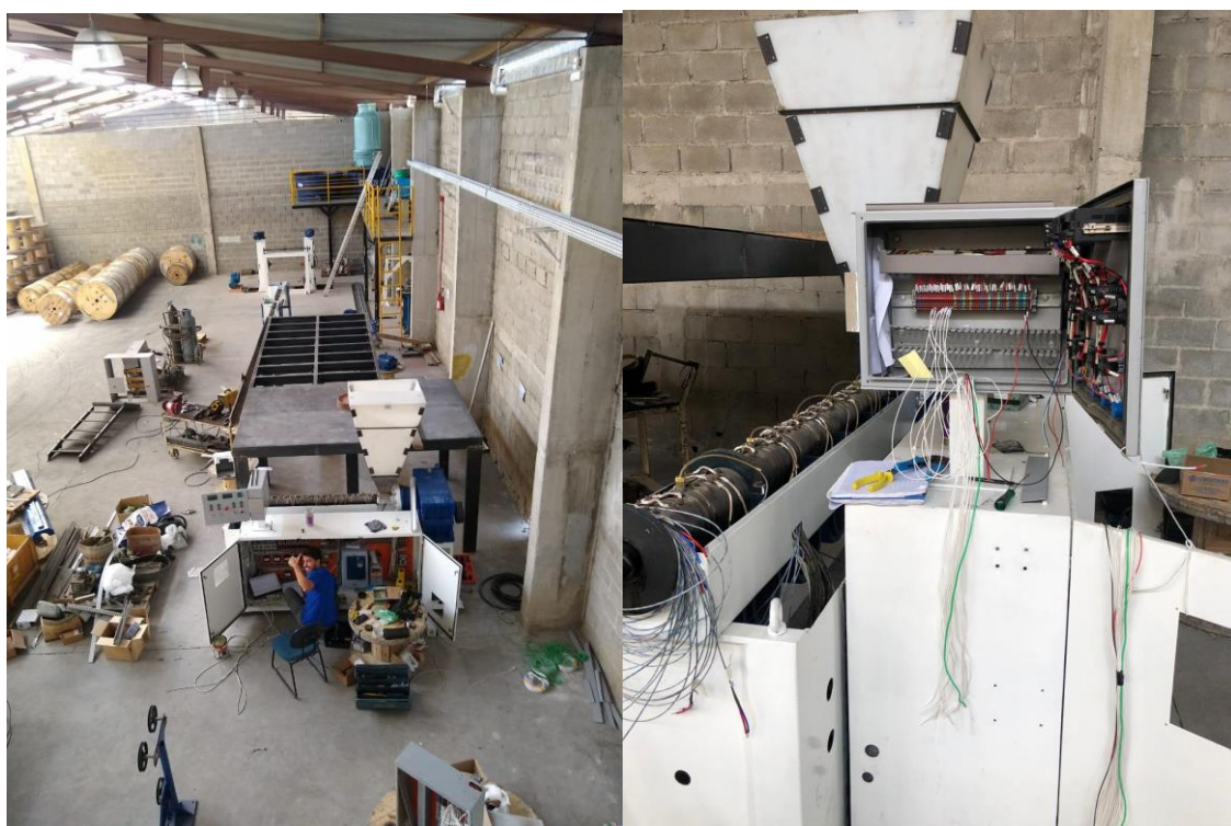
Figura 26.d: Montagem do corpo e mezanino da extrusora;
