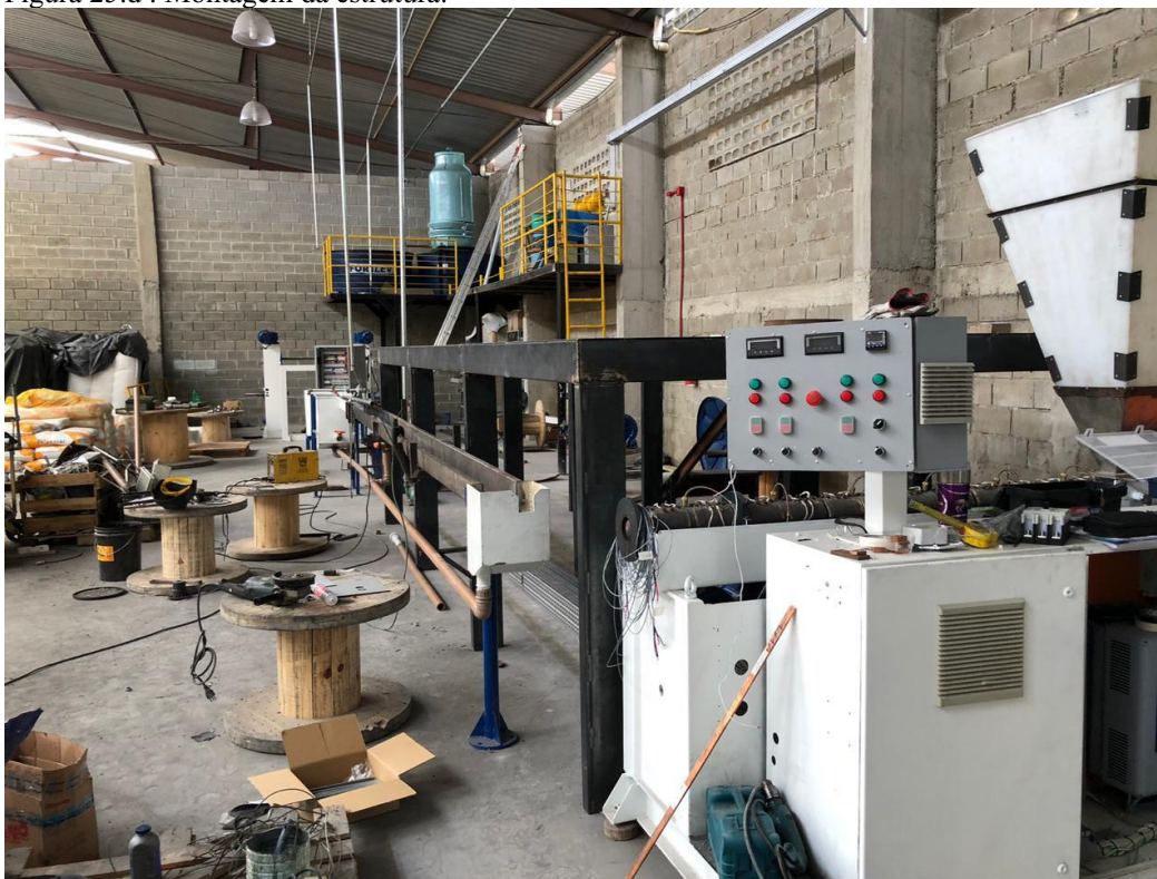
Figura 25.d : Montagem da estrutura.
