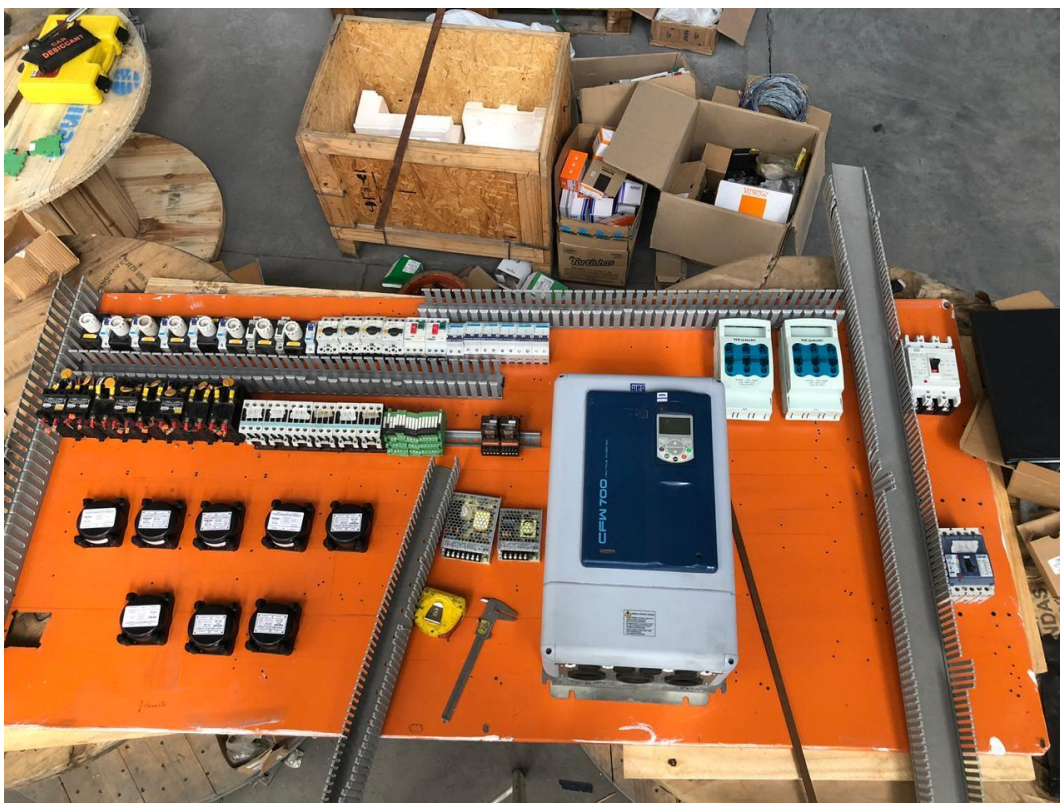
Figura 26.a: Pré montagem dos componentes do quadro principal
