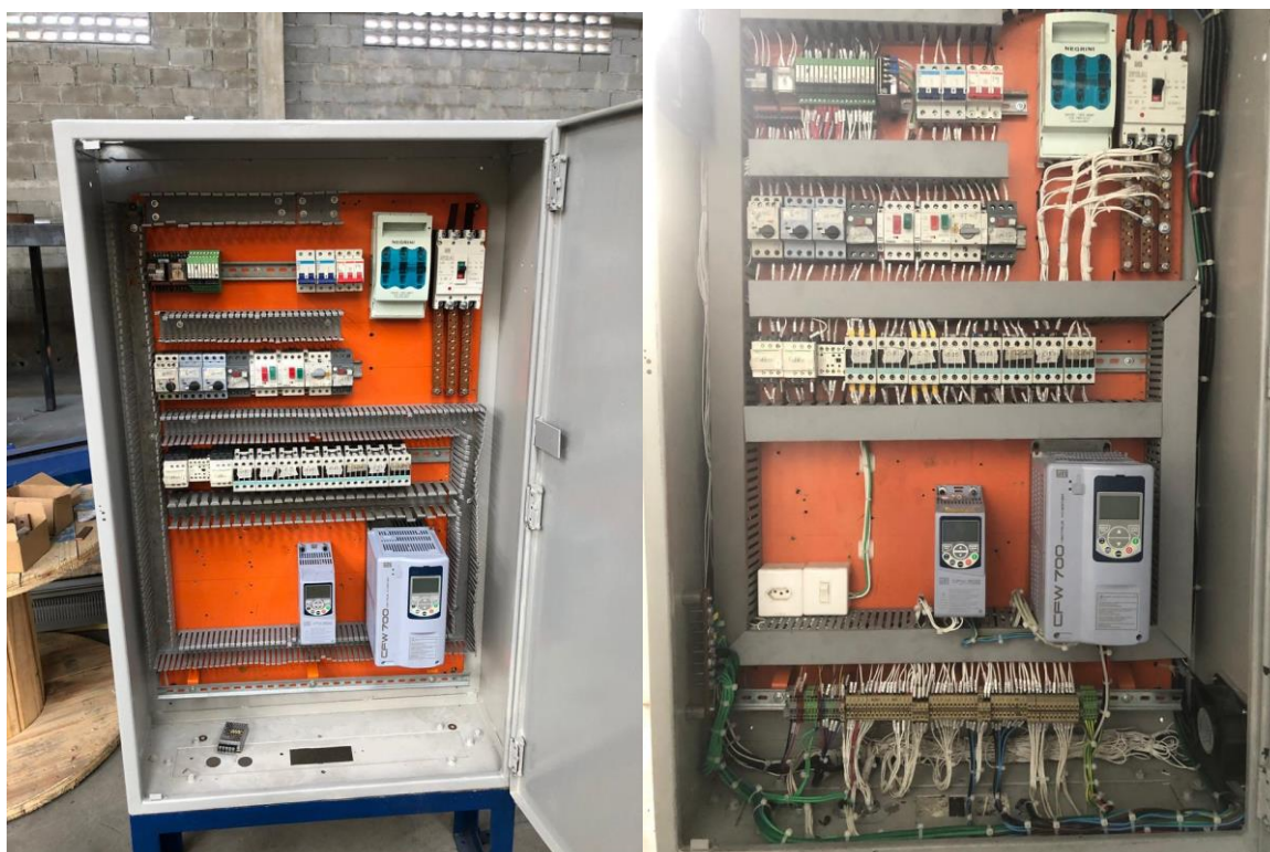
Figura 26.c: Montagem do painel do desbobinador.
