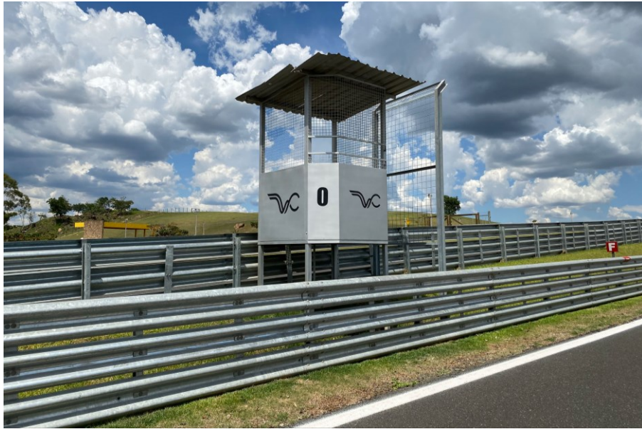
Figura 18: Cabine de Fiscalização
