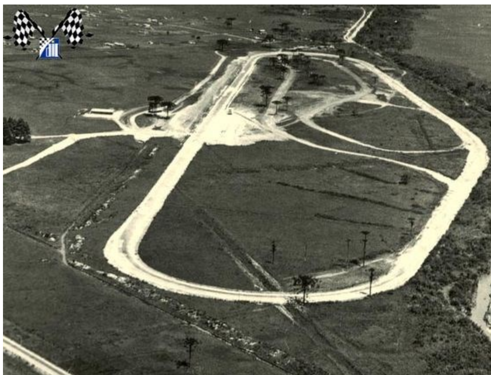
Figura 15: Construção do autódromo de Pinhais
