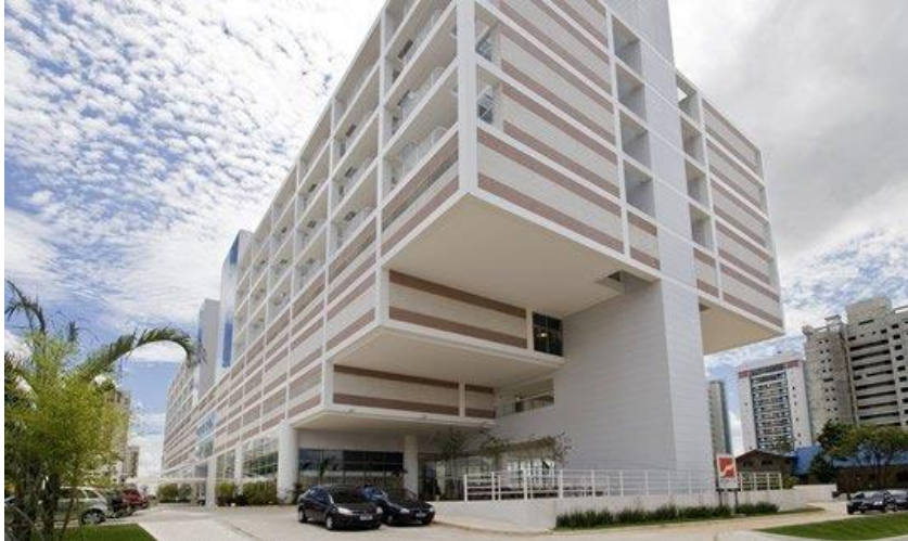
Figura 9. Fachada do Hospital e Maternidade São Luiz - Unidade Anália Franco
