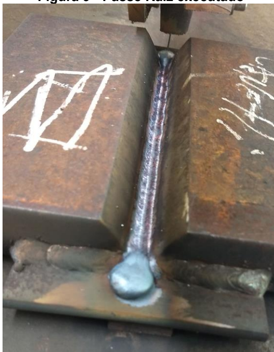
Figura 9 - Passe Raiz executado
