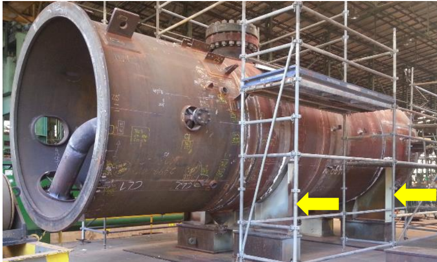
Figura 55: Visão geral do vaso de pressão sobre os suportes
