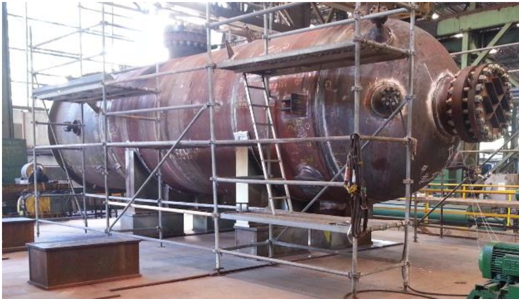
Figura 37: Vaso de pressão posicionado para o teste hidrostático
