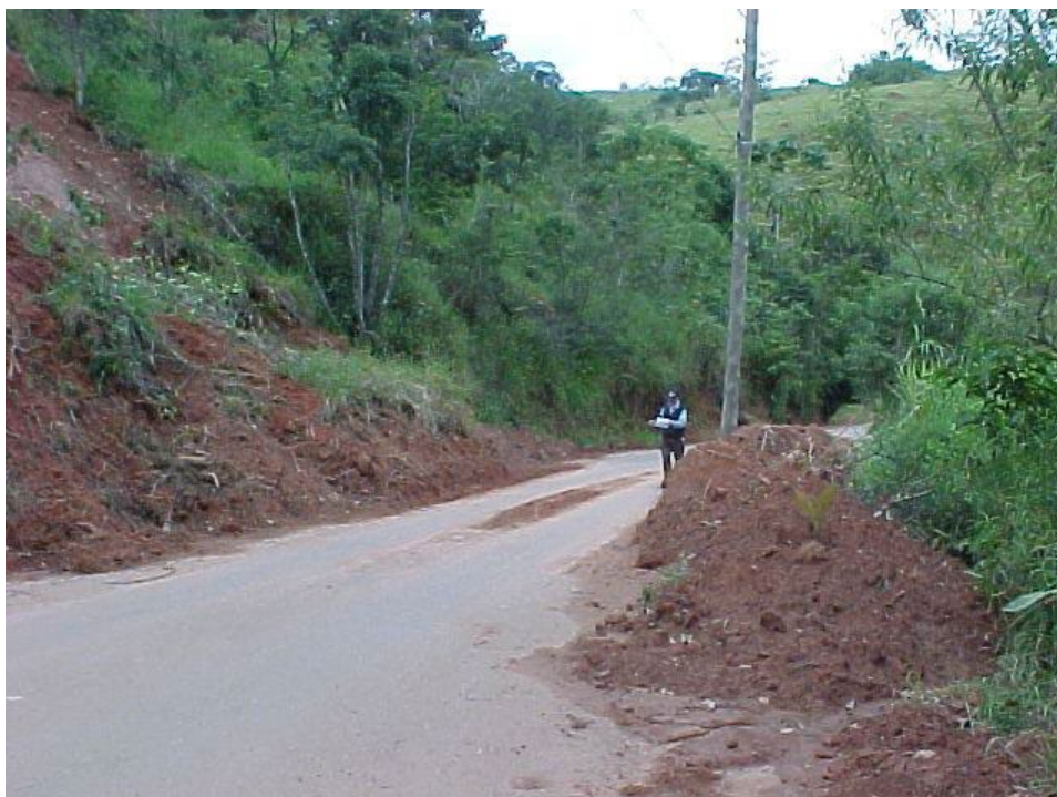
Figura 1. Escorregamento de taludes de estrada rural e deposição de terra ao lado oposto, próximo a rios e córregos (Fonte: CATELANI, et al. , 2005)
