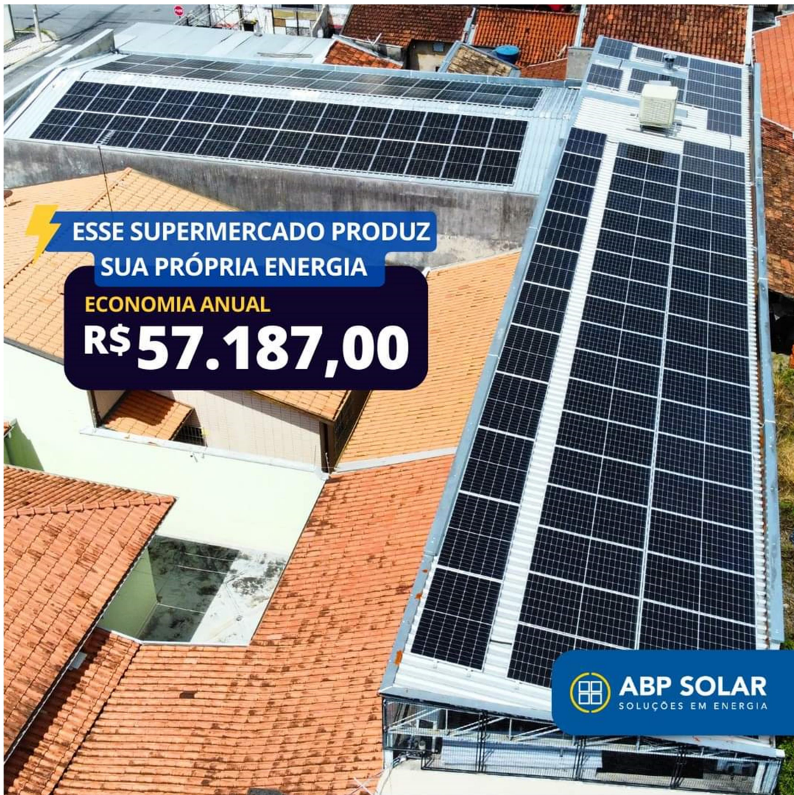
FOTO 3: Instalação de placas solares ABP em supermercado de Taubaté
