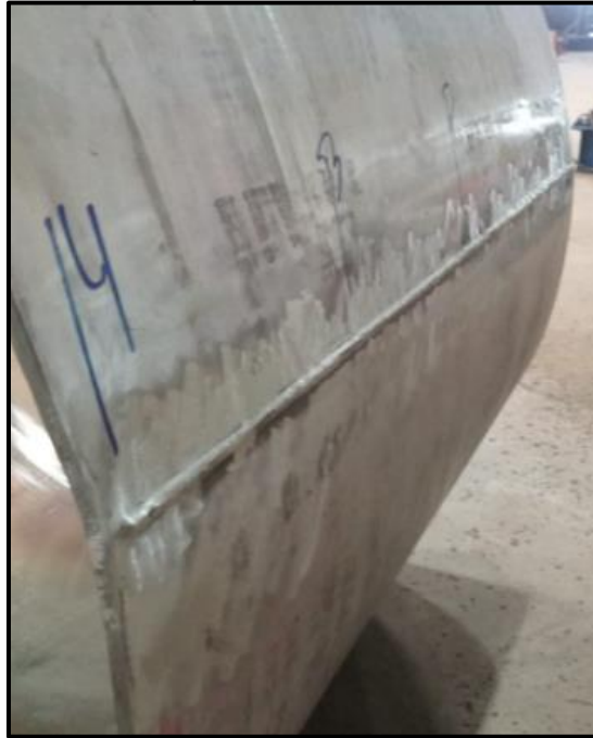
Figura 41 – Solda longitudinal da virola do corpo do vaso
