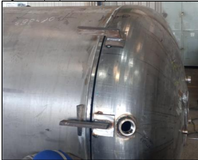
Figura 43 – Montagem do tampo superior com o corpo
