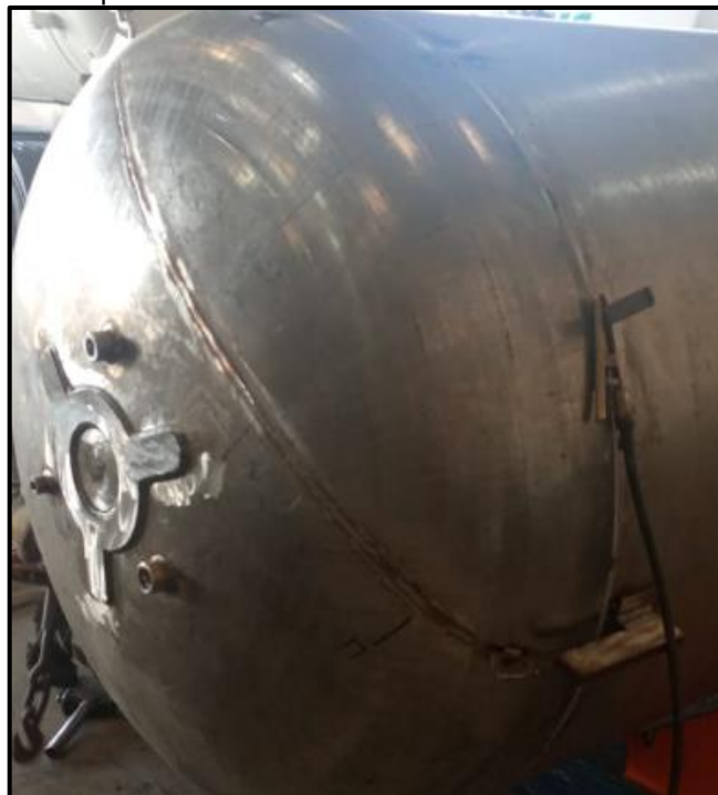
Figura 44 – Montagem do tampo inferior
