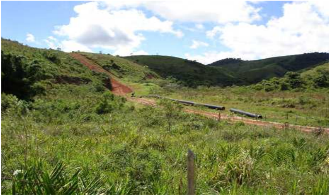
Figura 45: Construção do Gasoduto Estrada dos Tropeiros – Silveiras-SP
