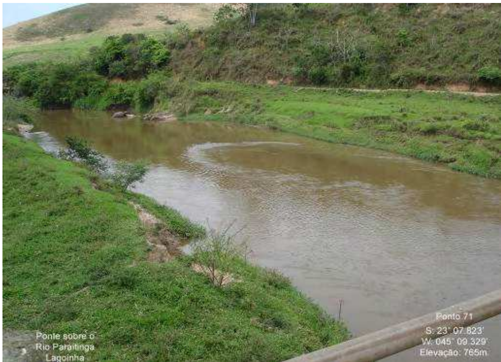
Figura 57: Ponte sobre o Rio Paraitinga - Lagoinha-SP
