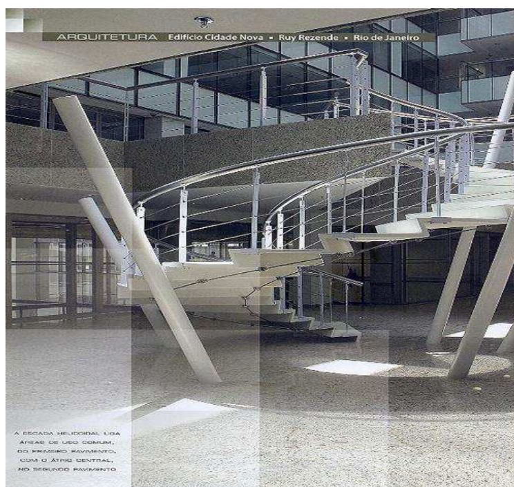
Figura 15 – Escada helicoidal no piso térreo Fonte: SILVA e PAIVA (2009).
