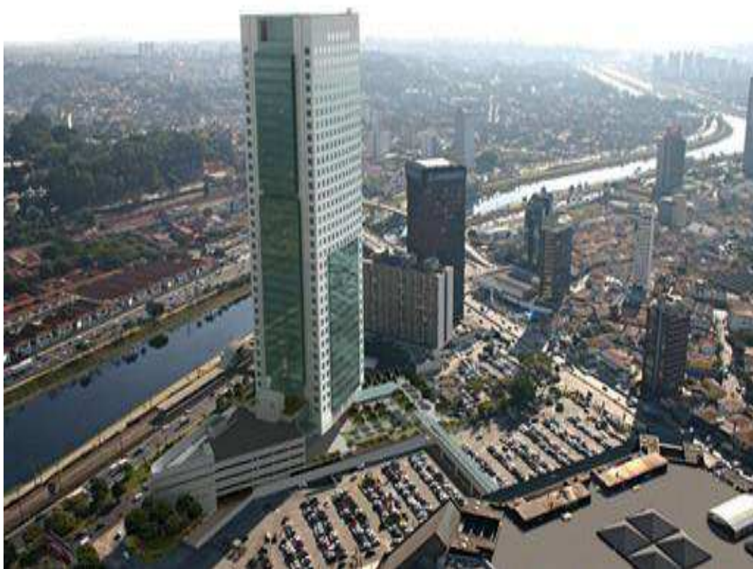
Figura 8 – Vista panorâmica do Eldorado Business Tower Fonte: GBC Brasil (2010).
