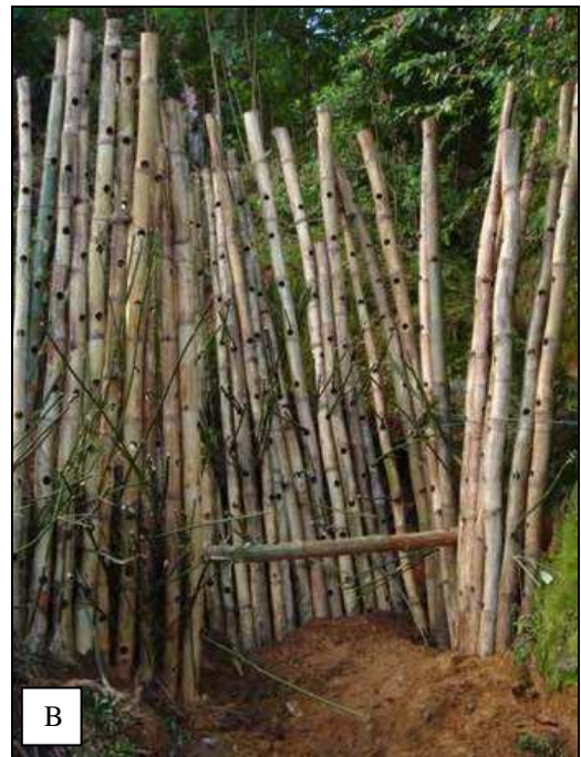
Figura 24. Instalação da estrutura de contenção da ravina menor, figura 24 A – início dos trabalhos; figura 24 B- trabalho concluído
