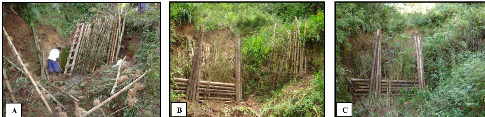
Figura 30. Acompanhamento de campo: figura 30A, montagem da contenção, imagem feita em dezembro de 2006; figura 30B, imagem de dezembro de 2007; figura 30C, imagem feita em março de 2008
