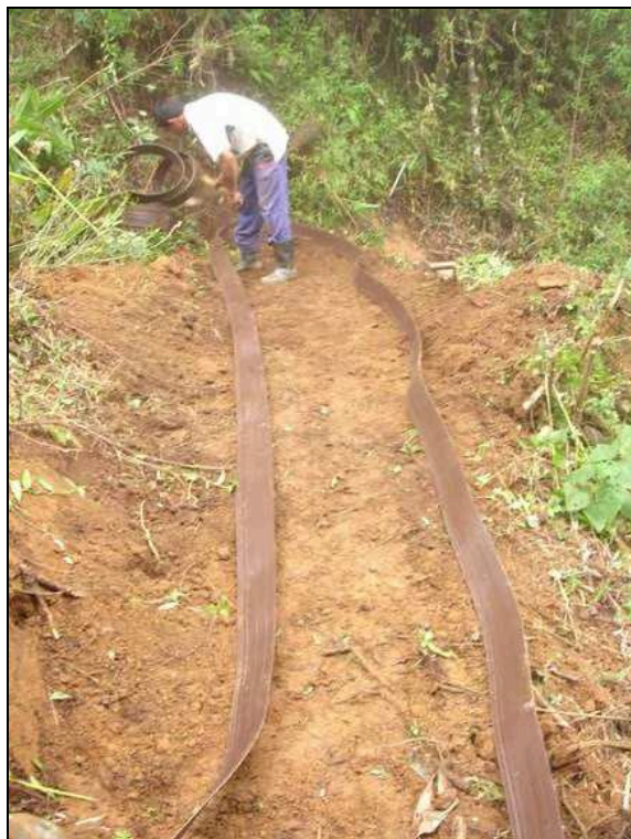
Figura 19. Preparo do terreno e colocação do limitador de jardim em PVC reciclado
