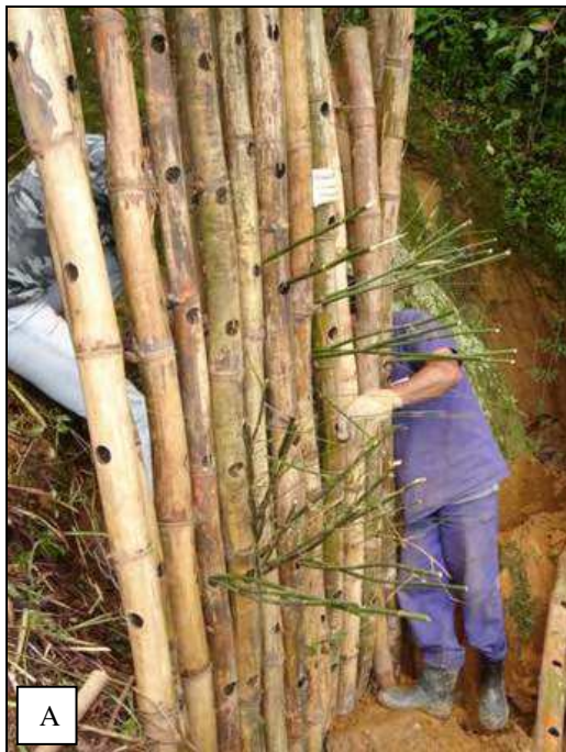
Figura 24. Instalação da estrutura de contenção da ravina menor, figura 24 A – início dos trabalhos; figura 24 B- trabalho concluído
