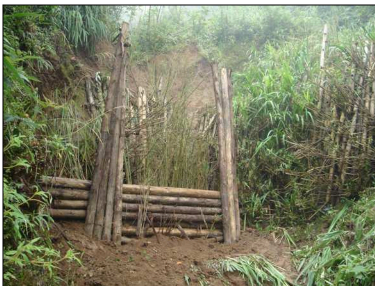
Figura 25. Contenção da ravina maior com suporte de mourões de eucalipto
