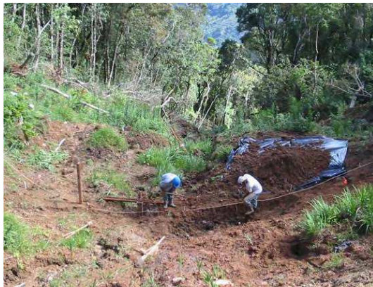
Figura 16. Reafeição da crista da barragem. Fonte: EMAE (2005)
