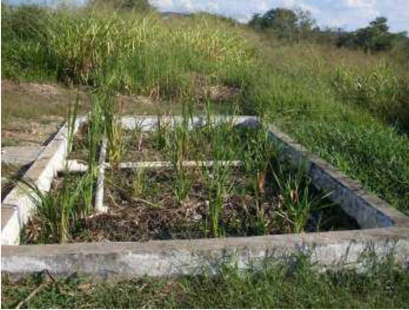
Figura 11: Vista lateral do leito cerca de 30 dias após manutenção
