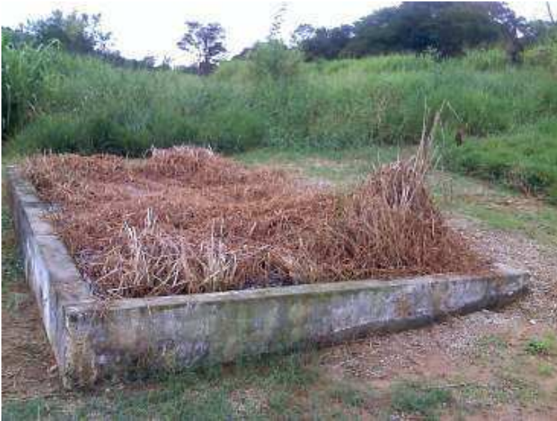
Figura 8: Vista lateral do tanque.
