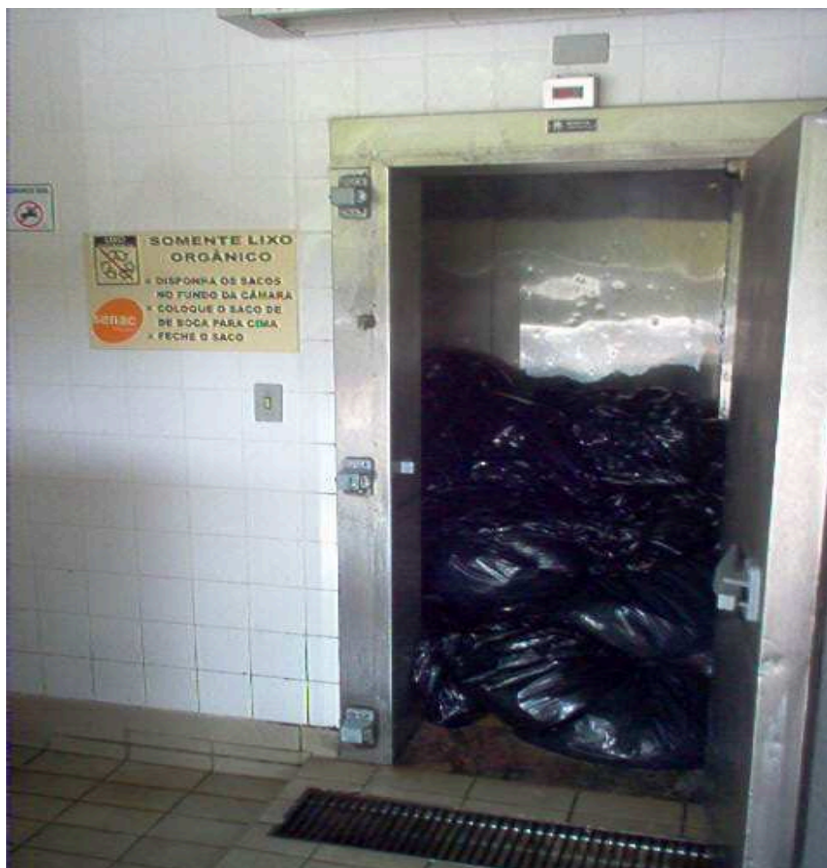
Figura 08: Câmara fria de resíduos orgânicos.
